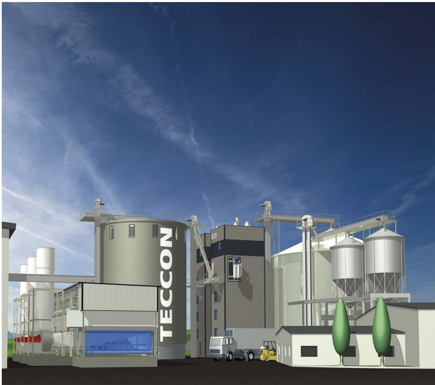
Projektierte Pelletieranlage mit zwei PELLET. TURM-Einheiten
